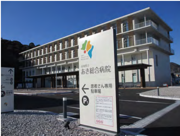
写真1. 高知県立あき総合病院
